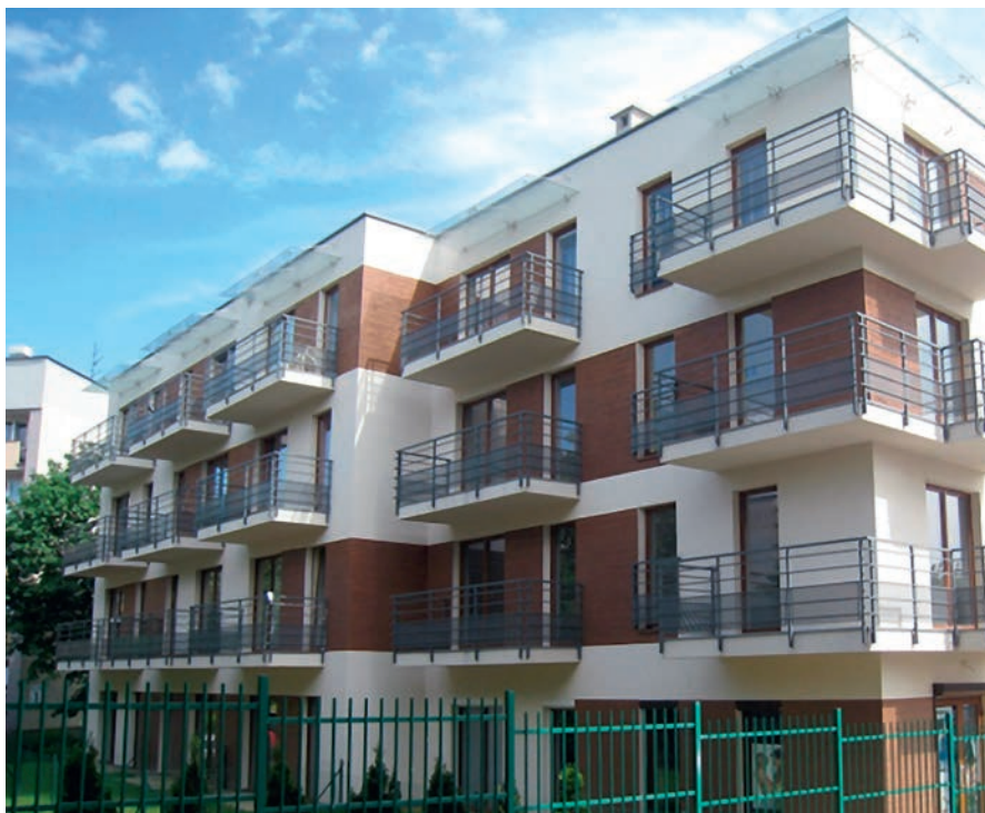
Budowa dwóch bloków w systemie developerskim
