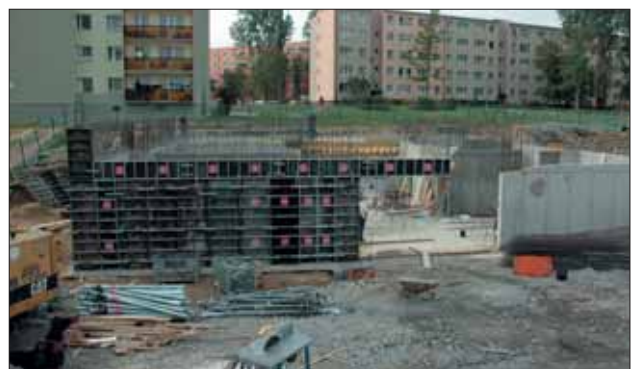
Aktualny postęp prac
