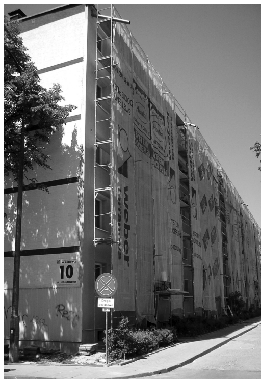
Ocieplany blok przy ul. Spółdzielców 10
